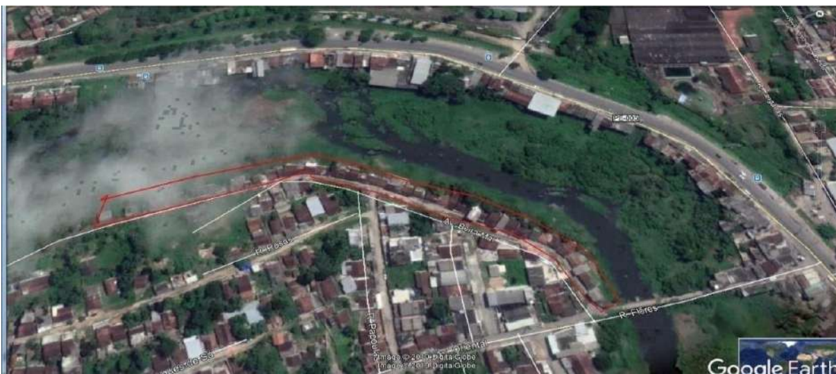
Figura 9 - Área de risco na ocupação de planície de inundação do Rio Capibaribe, na Comunidade de Penedo sujeita a inundação bruscas e/ou gradual
